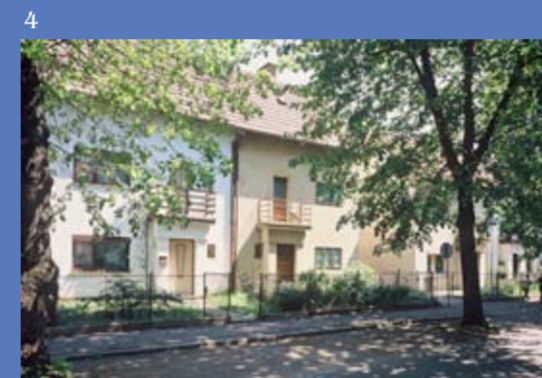
4 Delavsko naselje vrstnih hiš Betnavska cesta, Maribor
